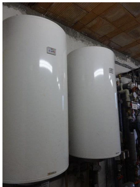
Obr. 3 Kombinované zásobníky teplej vody Dražice OKC 180
